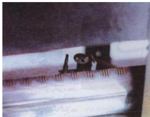
مجموعه اجاق، پیلوت، ترموکوپل و قندک پگ بخاری گازی
